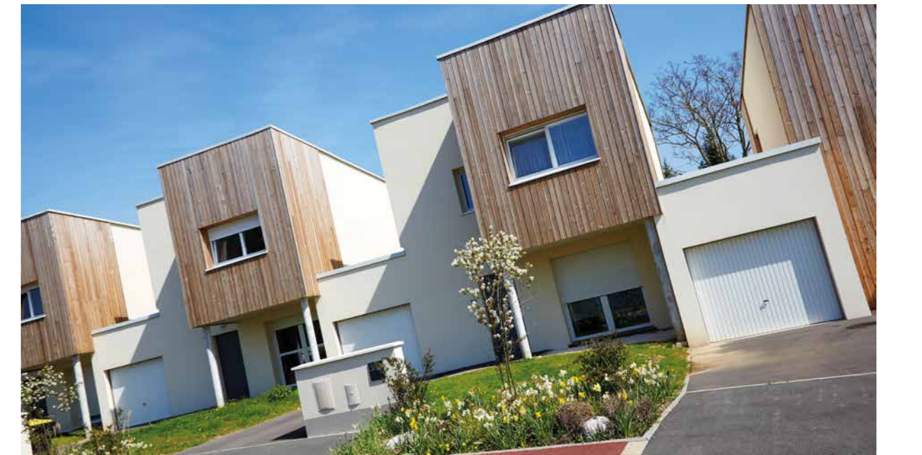
Lens, 16 logements individuels, rue des Bergeronnettes
