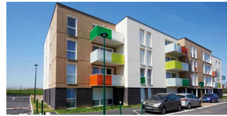
Achicourt, 30 logements, rue Marc Lanvin
