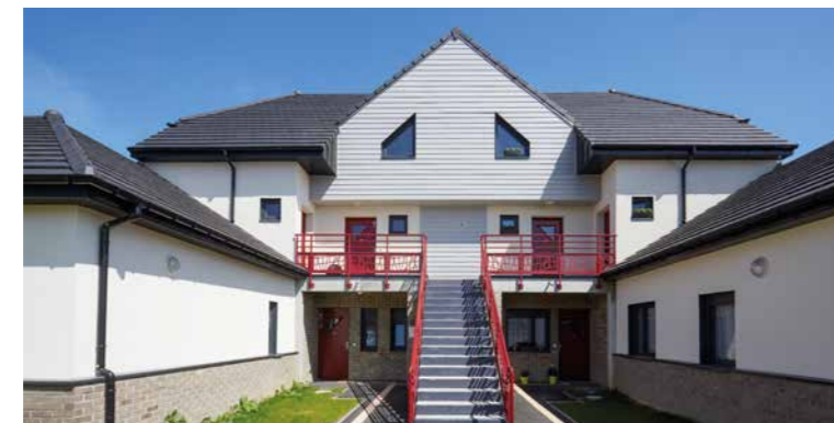
Givency-en-Gohelle, 5 logements, place d'Or, rue Dégreaux
