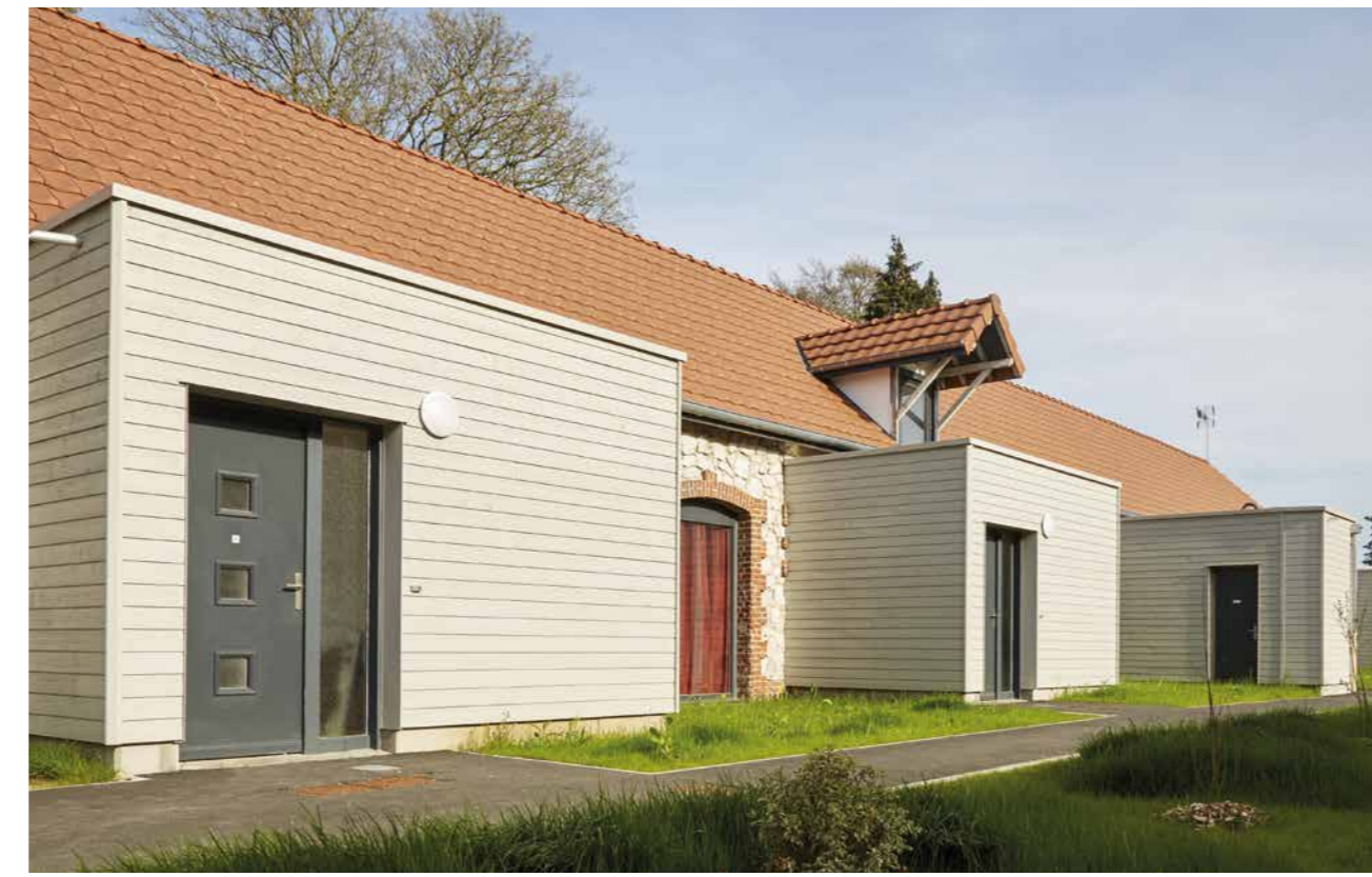
Adinfer, 16 logements intergénérationnels, rue d'Hendecourt
