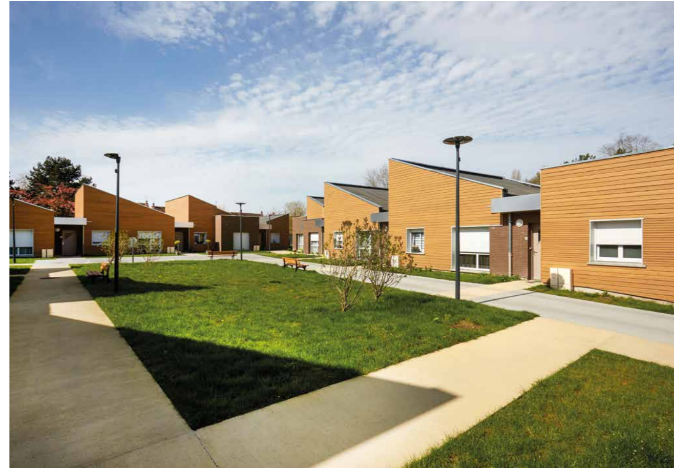
Montigny-en-Gohelle, béguinage de 12 logements, rue du Parc, résiden ce les Lilas
