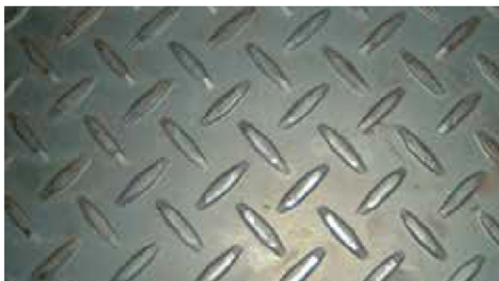
Plateforme piétonnière en tôle galvanisée larmée.
