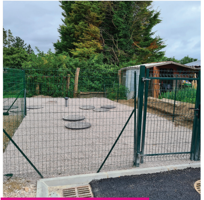
Les importants travaux d'assainissement réalisés sont aujourd'hui invisibles.
