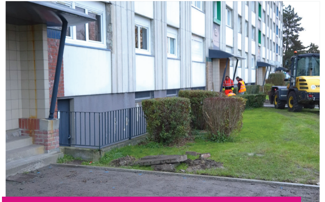
Un enrobé sera posé dans les allées d'accès aux halls.
