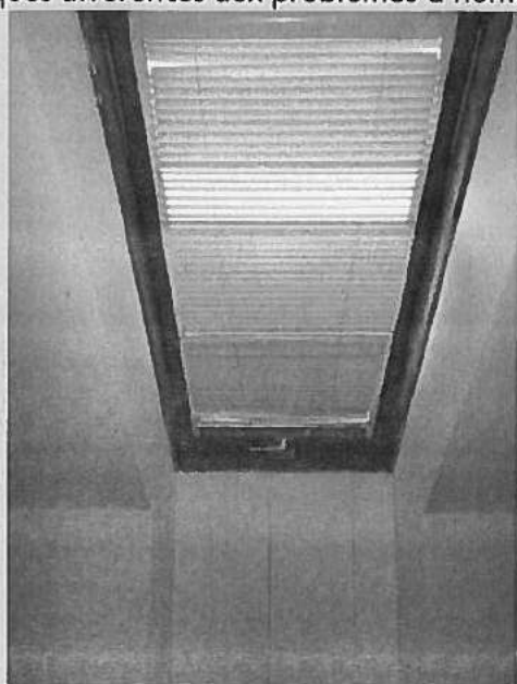
Vue rapprochée sur l'un des velux avec menuiserie (bois) d'origine. A noter juste sous les boiseries, des marques afférentes aux problèmes d'humidité
