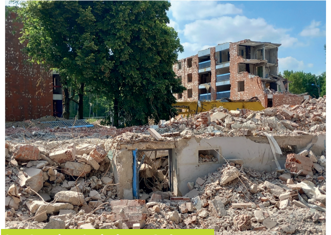
Les Jasmins, Jacinthes et Anémones en cours de démolition
